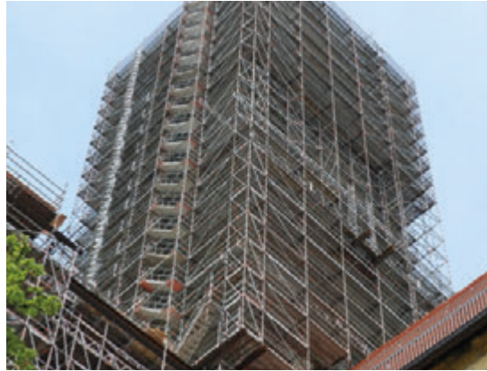
Die XERVON-Gerüstkonstruktionen an der Amberger Basilika sind bis ins kleinste Detail geplant und durchgerechnet – ein eindrucksvolles Beispiel für fachmännische Gerüstbautechnik
